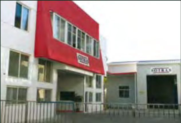
SOTRAS CHINA WAREHOUSE
